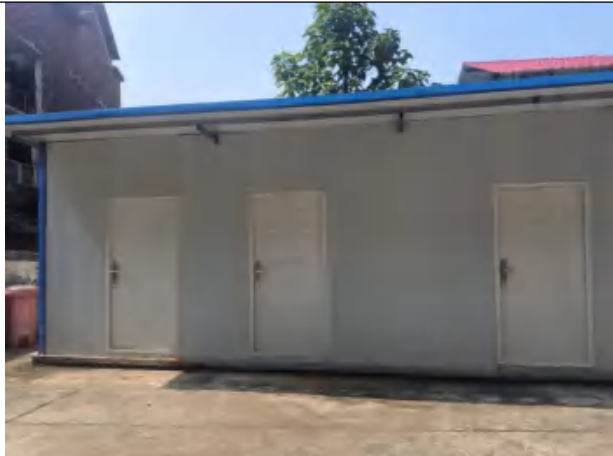
一般固废暂存间
